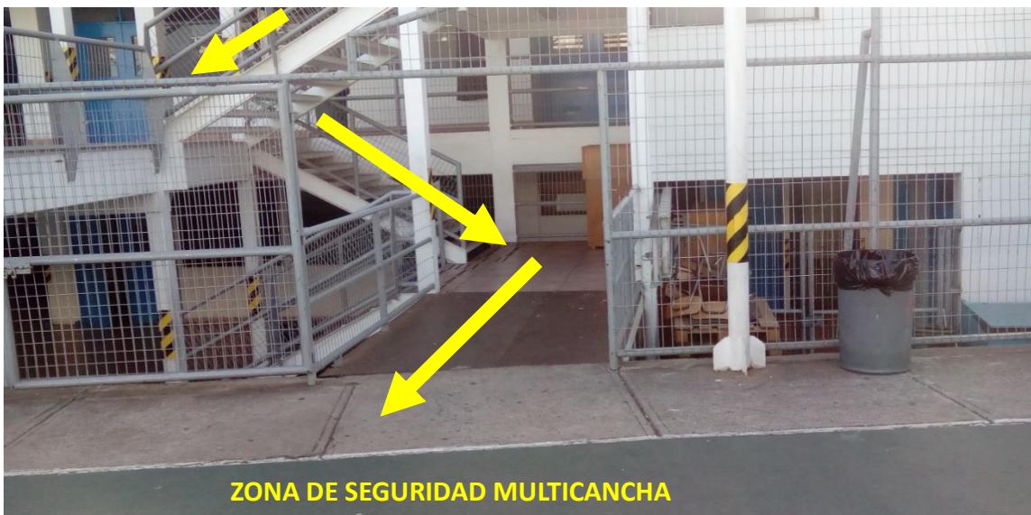
PUENTE DE EVACUACIÓN HACIA MULTICANCHA
