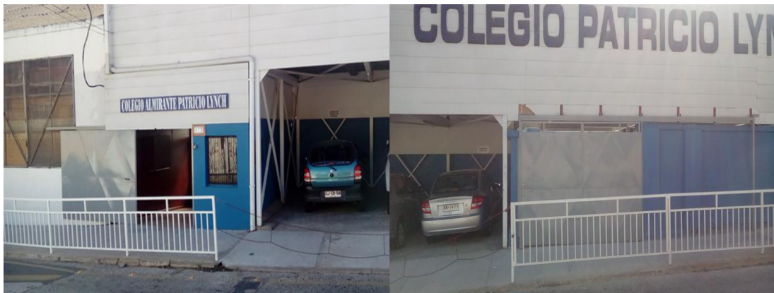
FRONTIS PUERTA DE ACCESO/SALIDA
